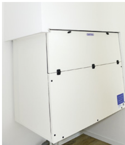
Das kompakte Lüftungsgerät erzielt einen Luftvolumenstrom von max. 390 m 3 /h.
