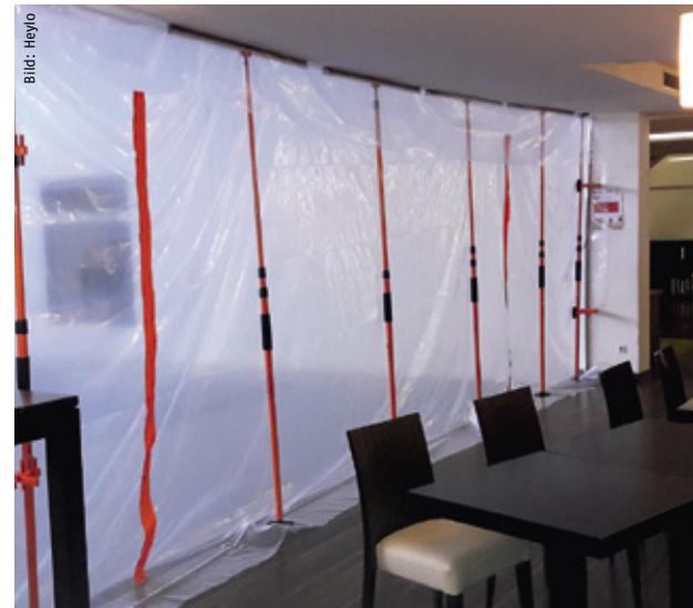
Eine Staubschutzwand schützt vor unliebsamem Dreck in schützenswerten Bereichen eines Gebäudes.
