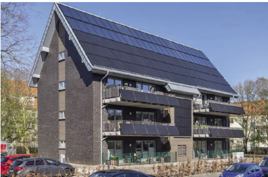
Das Gebäude wird zu ca. 70 % energieautark sein. Ermöglicht wird dies, neben einer gut gedämmten Gebäudehülle, durch die PV- und Solarthermieanlagen.
